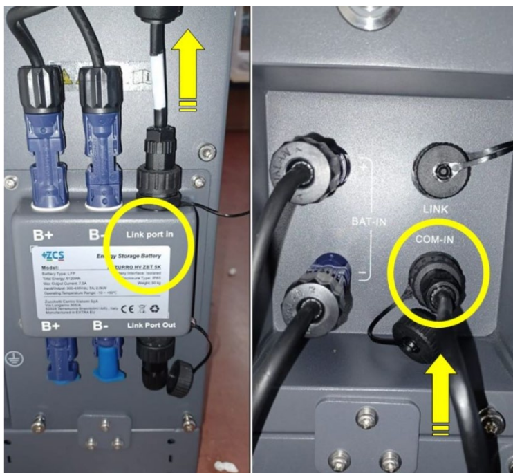
Figura 116 - Connessioni comunicazione: BDU e primo modulo batteria
