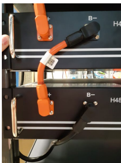
Figura 45 - Connessione di potenza (negativo) fra BMS e ultimo modulo batteria
