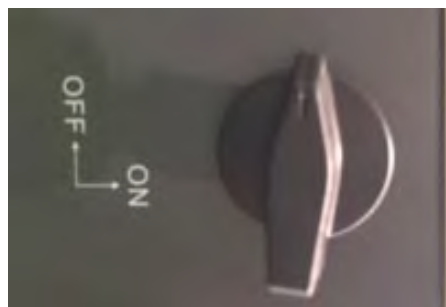
Figura 56 - Sezionatore fotovoltaico
